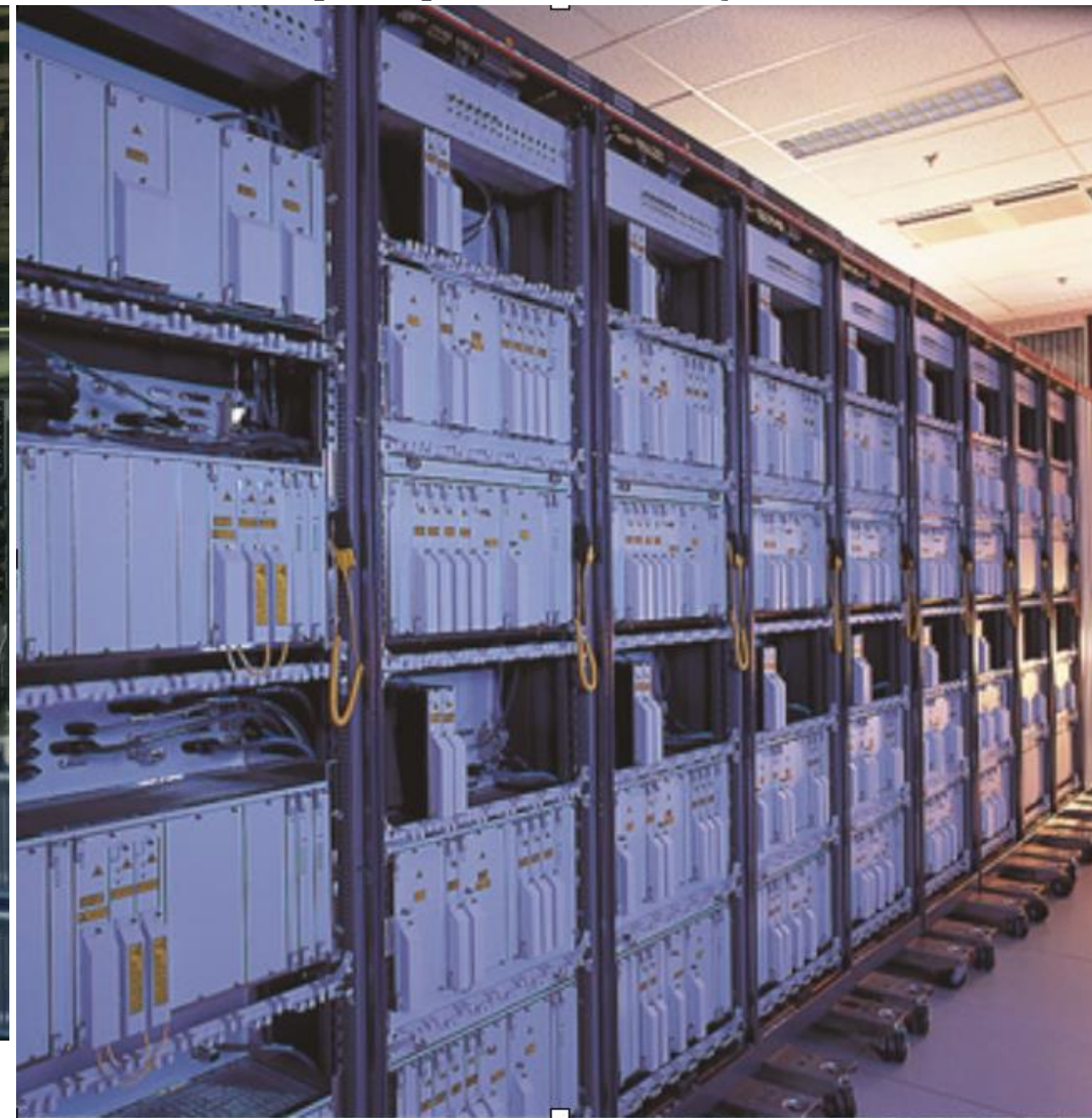
Figure 3. Terminaux sous-marins transatlantiques multi Tbit/s dans une station de Lannion (câble Apollo).
