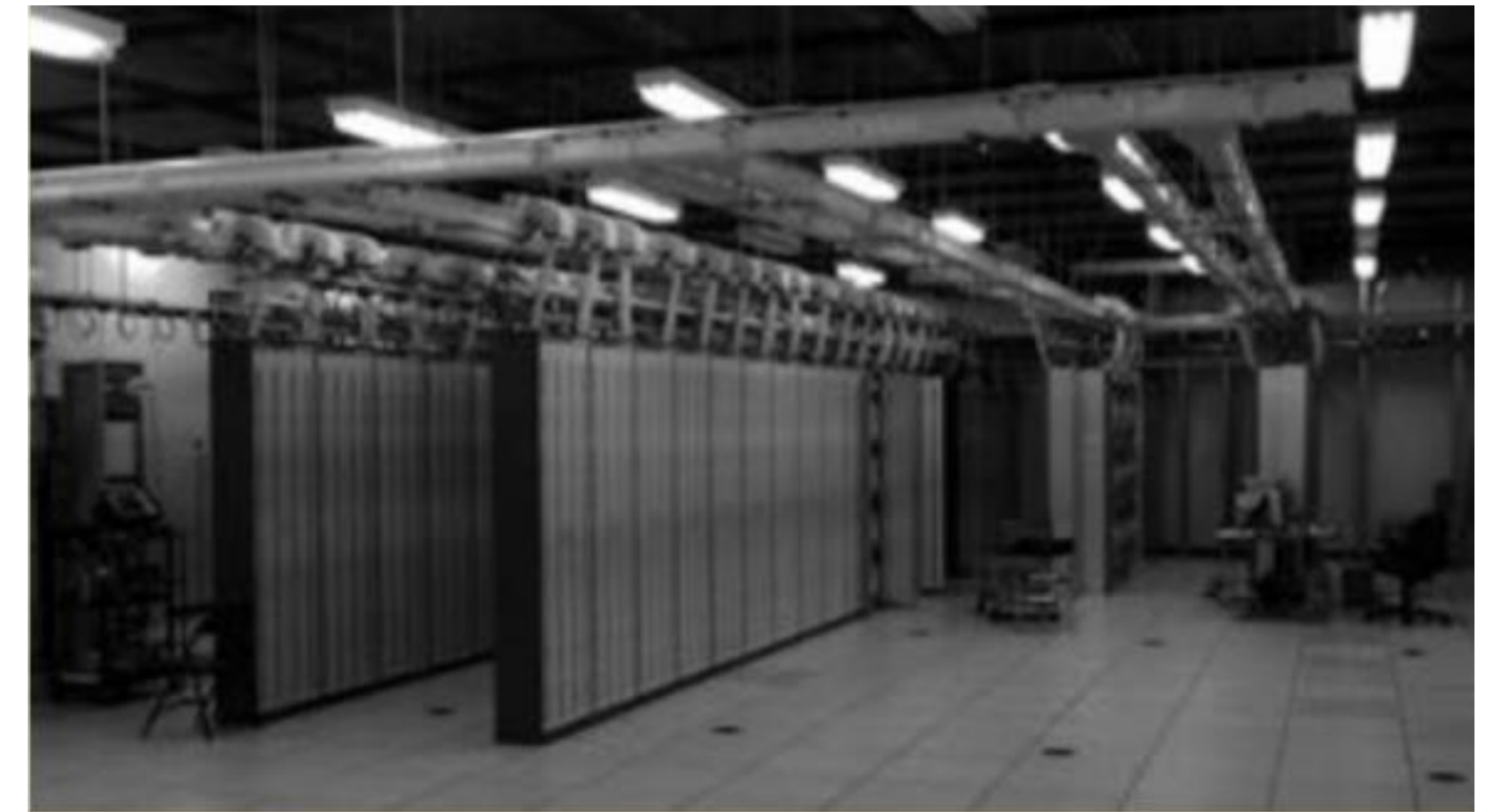
Figure 3. Terminaux sous-marins transatlantiques multi Tbit/s dans une station de Lannion (câble Apollo).
